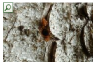
Abb. 2: Mit Harz verklebtes Bohrmehl am Einbohrloch (© F. Maier)
